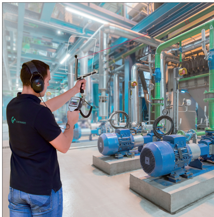
Dokładne wykrywanie nieszczelności przy pracy z wskaźnikiem laserowym i wbudowanej kamerze.
